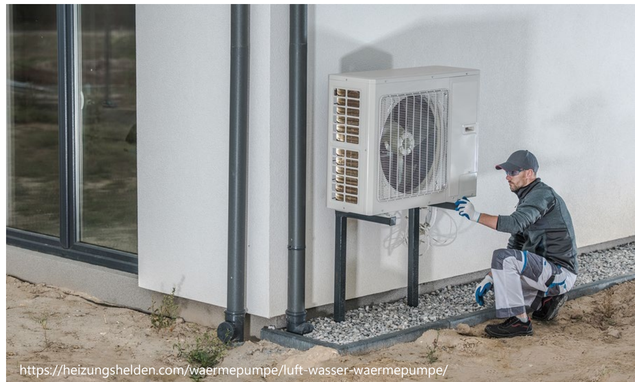
https://heizungshelden.com/waermepumpe/luft-wasser-waermepumpe/ Luft-Wasser-Wärmepumpen (teilweise Aussenmontage)
