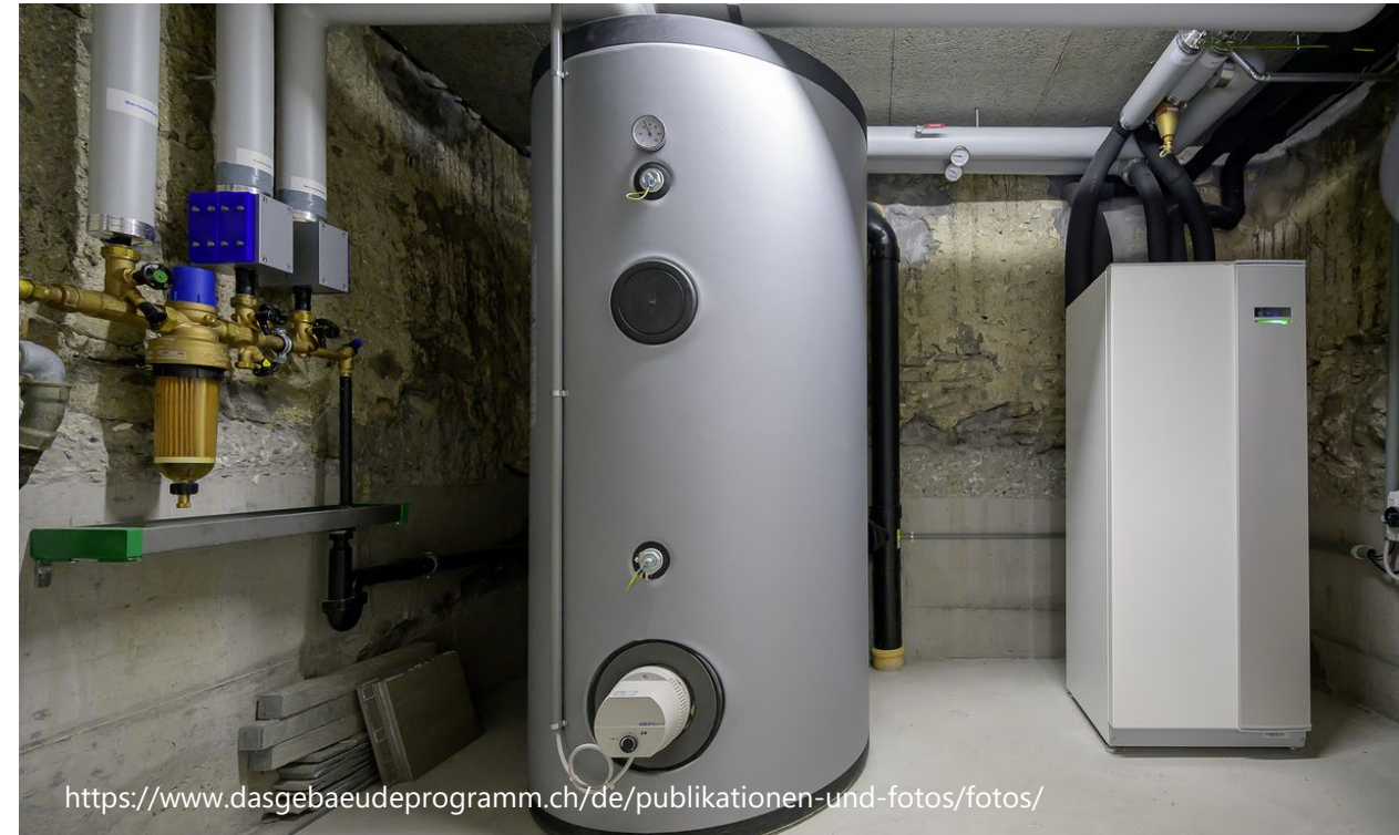
Erdsonden-Wärmepumpe
