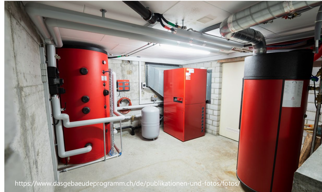
Luft-Wasser-Wärmepumpen (Innenaufbau)
