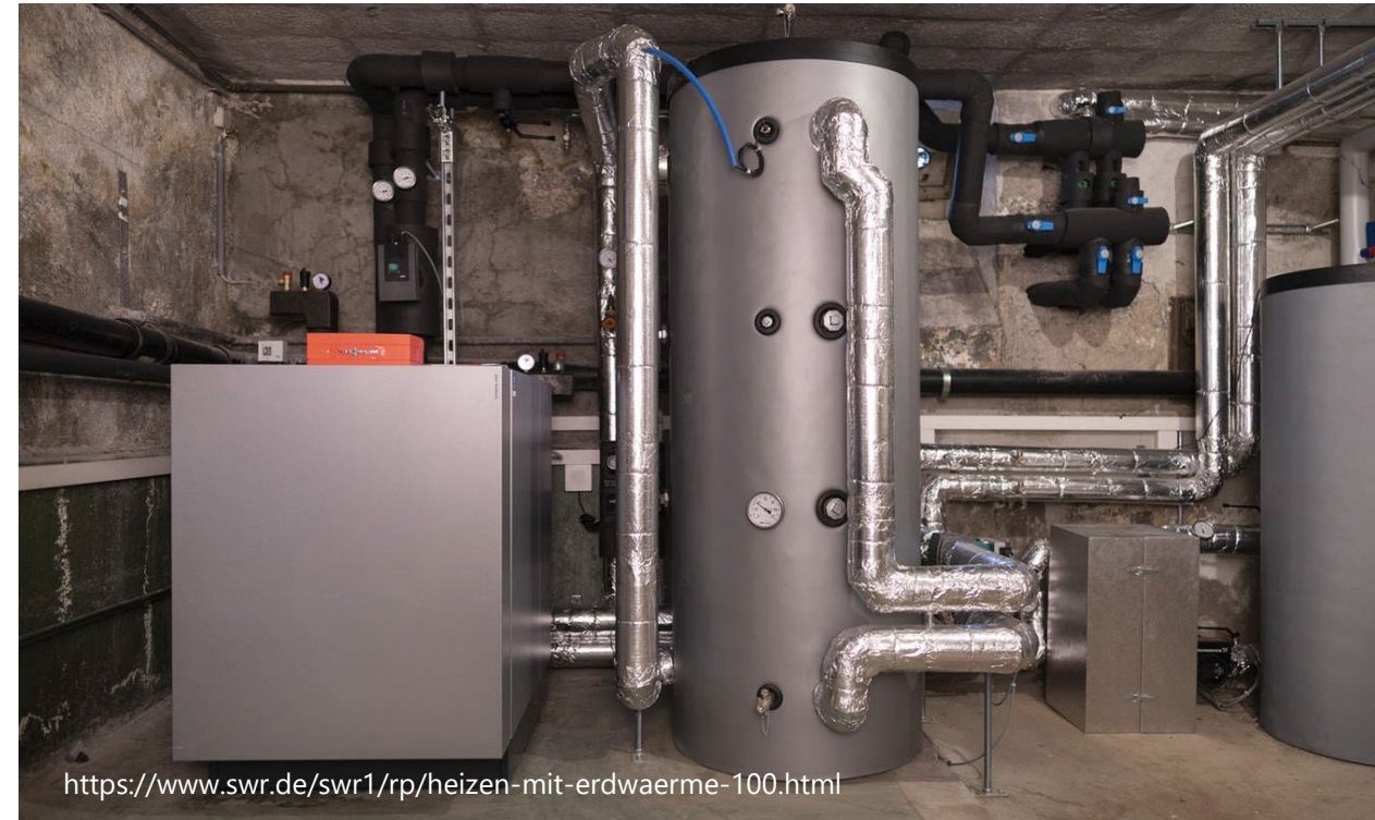
Erdsonden-Wärmepumpe
