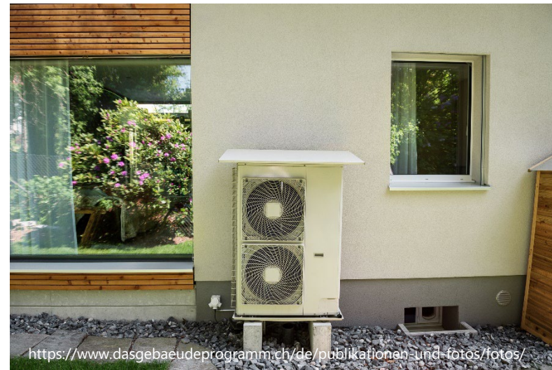
Luft-Wasser-Wärmepumpen (oben: Innenaufbau, unten: teilweiser Aussenaufbau)
