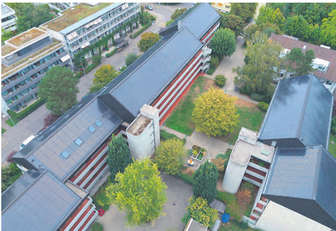
Die Fotovoltaikanlage auf der Alterssiedlung Drei Brunnen.
